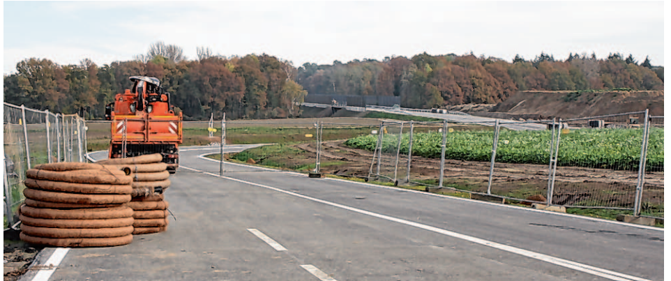
Blick von der L117 auf die B221n: Am 9. Dezember wird die Straße freigegeben. Foto: pkü
